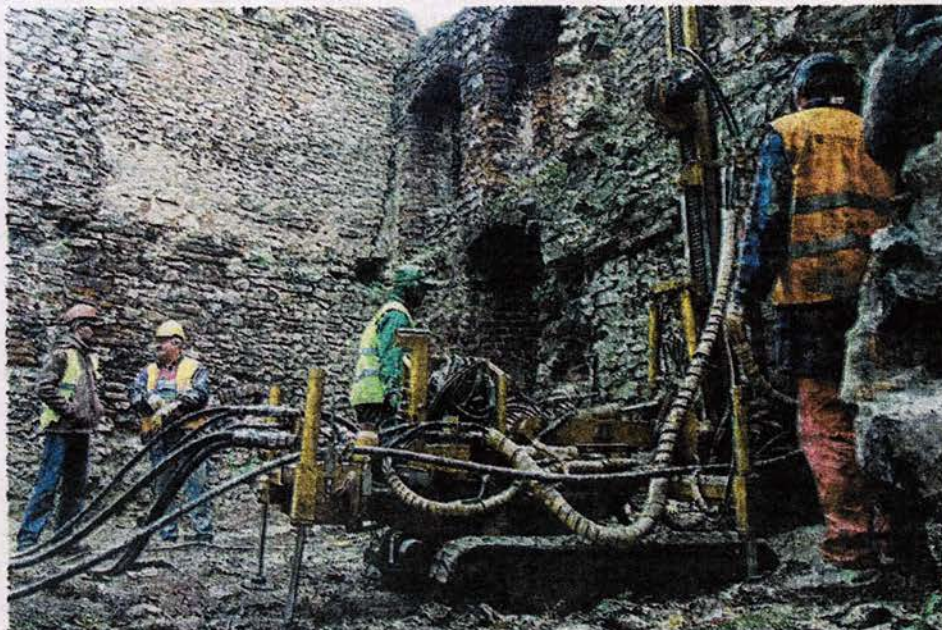
W pierwszej kolejności firma musi wzmocnić fundamenty zamku.
